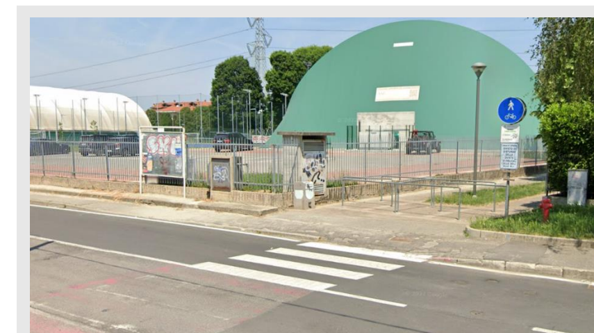
La connessione pedonale fra via Matteotti e via Aldo Moro, può divenire il fulcro della rete interna, dedicata alla mobilità non motorizzata; bisognerà pertanto porre l'attenzione sulla riqualificazione dell'attraversamento di via Carducci.
