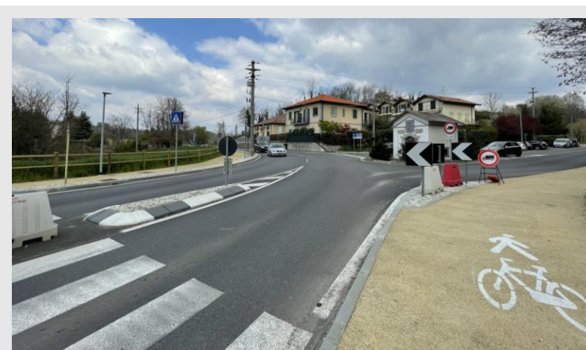
Nodo via del Mulino / via Martiri della Libertà recentemente adeguato con l'insierimento di attraversamenti e percorsi ciclopedonali lungo strada.
