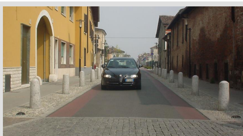
Ambito urbano centrale: franchi laterali polivalenti, ad uso ciclabile con funzione di riduzione ottica della carreggiata, realizzati con verniciatura dell'asfalto. Frazione di Fornaci, Brescia. Archivio META / arch. F. Jappelli
