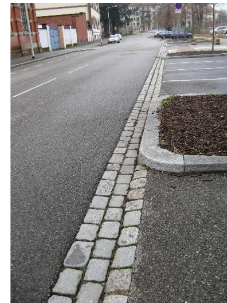
Fig. 4.6.iii – Esempio di canaletta di lo scolo delle acque
