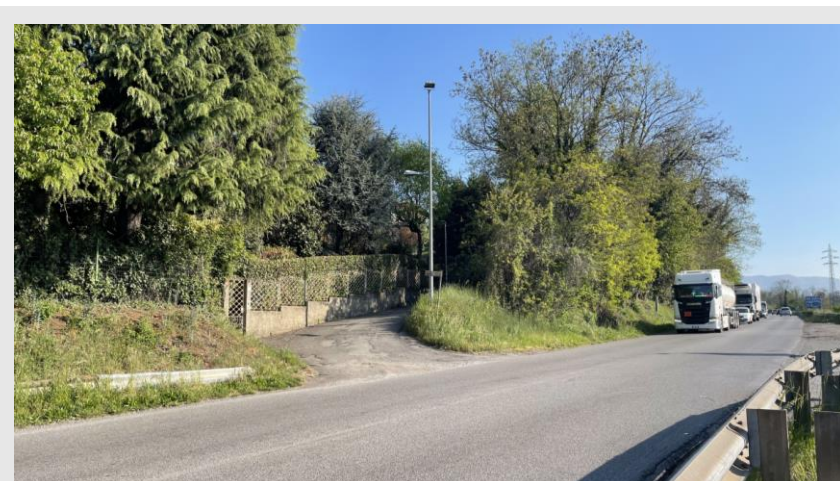
Gli innesti di via Lecco e del frontistante piazzale sono risolti con geometrie inadeguate e tali da non garantire la piena sicurezza delle manovre veicolari. Ciò vale in particolare per le svolte a sinistra.
